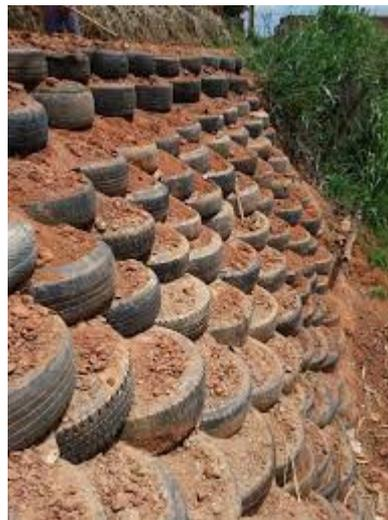
*Figura 5. Muro de pneus.*
