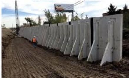
*Figura 6. Muro de flexão com contrafortes.*
