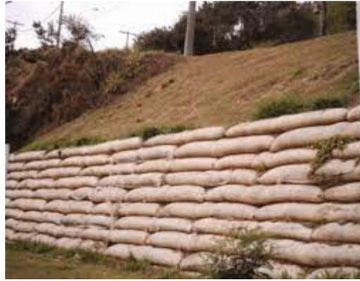
*Figura 7. Muro de sacos solo-cimento.*
