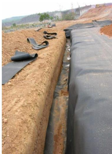
FIGURA 7 – TRINCHEIRA DE ANCORAGEM NA UHE SÃO SALVADOR
