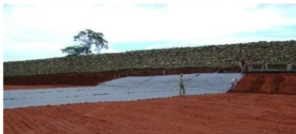
FIGURA 8 – COLOCAÇÃO DA GEOMEMBRANA NA UHE SALTO
