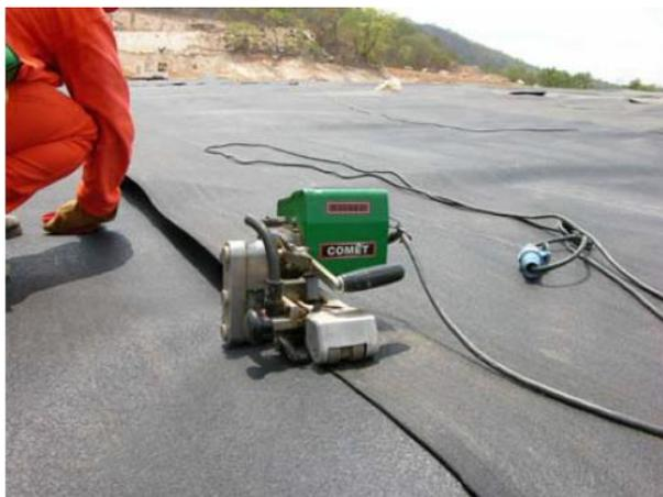
FIGURA 6 – EMENDA POR FUSÃO TÉRMICA
