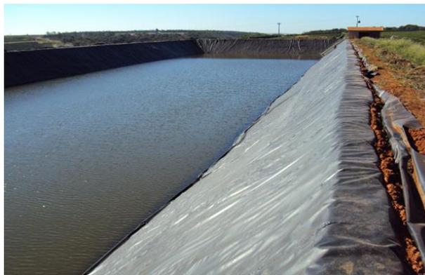
FIGURA 4 – APLICAÇÃO DE GEOMEMBRANA DE PEAD EM RESERVATÓRIO
