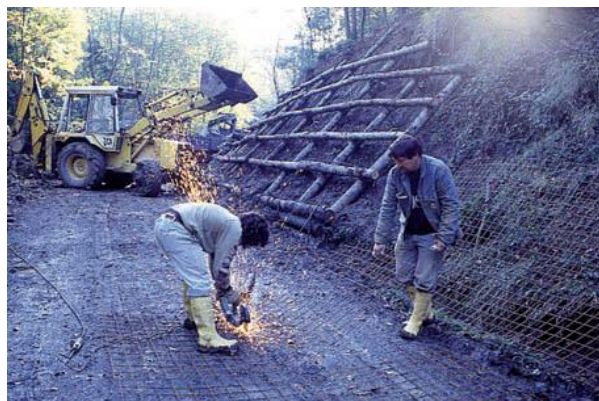
FIGURA 38 – CORTE DA GRADE METÁLICA
