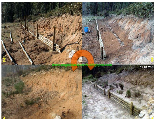
FIGURA 51 – ESQUEMA EXEMPLIFICANDO A CONSTRUÇÃO DE UMA PALIÇADA
