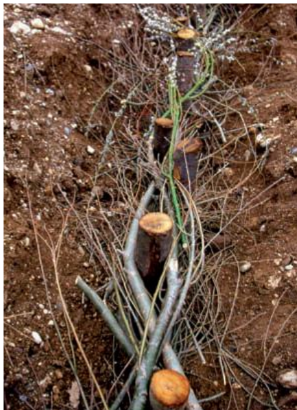
FIGURA 84 - VIMINATA VIVA APÓS O PASSO 5
