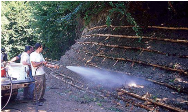
FIGURA 48 – IRRIGAÇÃO DO TALUDE
