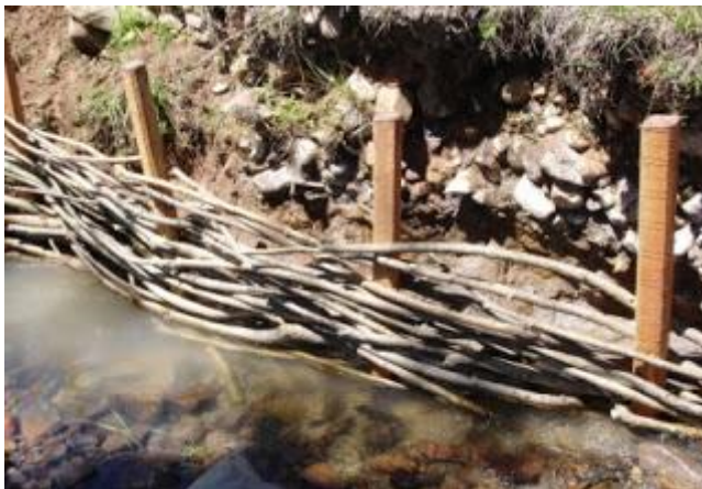
FIGURA 86 – EXEMPLO DE OBRA COM ESTACA VIVA
