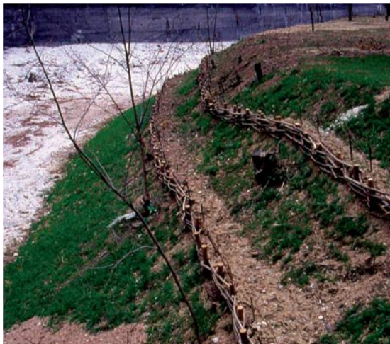
FIGURA 85 – EXEMPLO DE OBRA COM ESTACA VIVA
