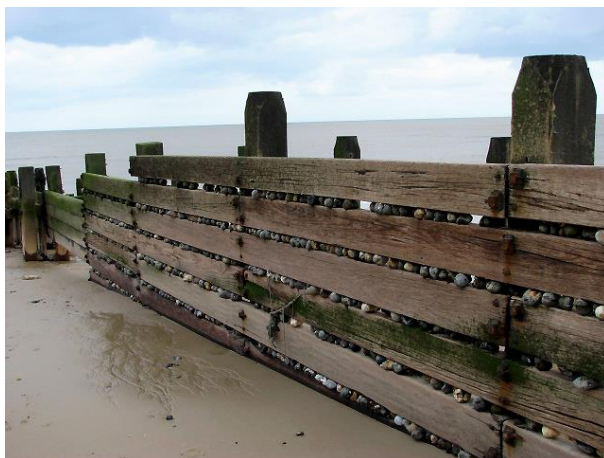
FIGURA 59 - BERÇO SIMPLES DE RÂMPROLAS CONCLUÍDO.
