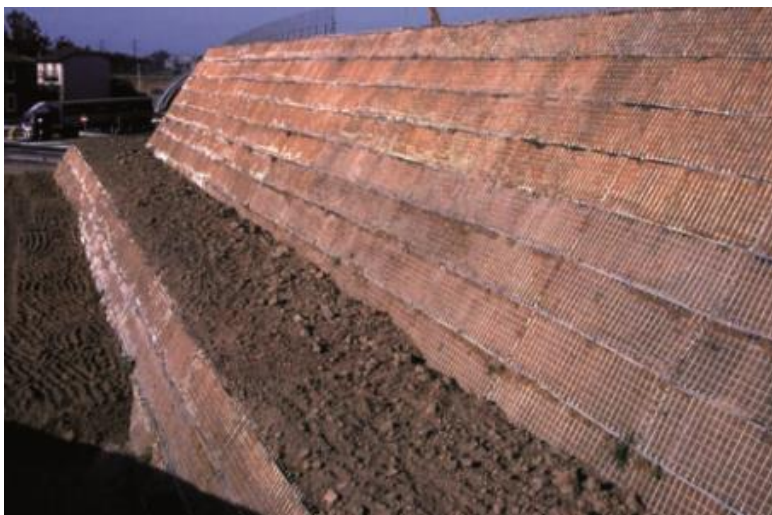
FIGURA 71 – EXEMPLO DE TALUDE ESTABILIZADO
