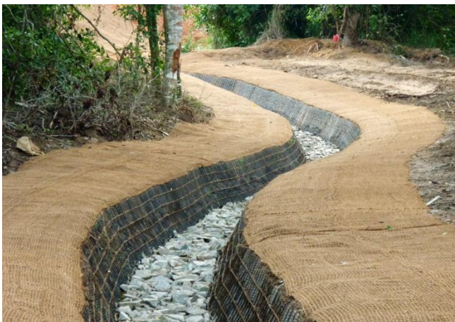
FIGURA 25 – CANALETA VEGETADA COM GEOGRELHA, MANTA GEOTÊXTEL, PEDRAS E VEGETAÇÃO.
