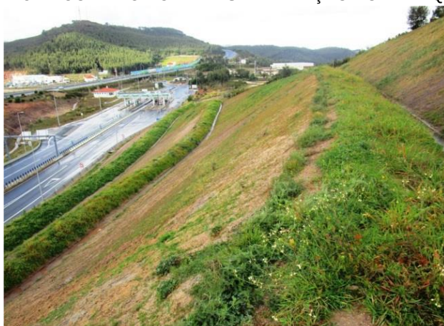
FIGURA 23 – TALUDE COM TÉCNICA DE ESTABILIZAÇÃO POR BANQUETA VIVA.
