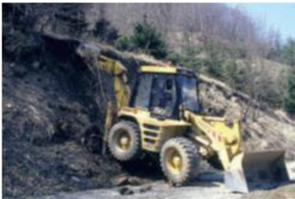
FIGURA 35 – EQUIPAMENTO A SER UTILIZADO
